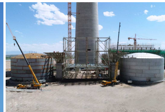
储罐与换热平台施工
